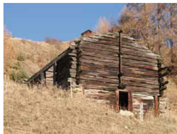
/ÉTAT DES LIEUX AU 1.12.2005 AVANT INTERVENTION
