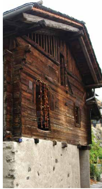
/VUE EXTÉRIEURE À L'ÉTAT ACTUEL MI-OCTOBRE 2009
