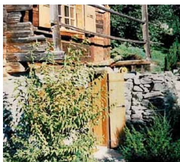
/ÉTAT AVANT DÉBUT DES TRAVAUX
