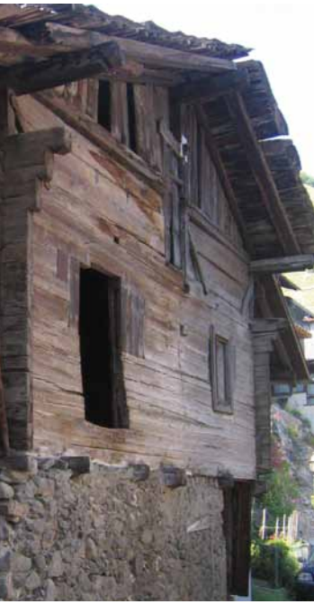
/ÉTAT DE LA FAÇADE SUD AVANT INTERVENTION
